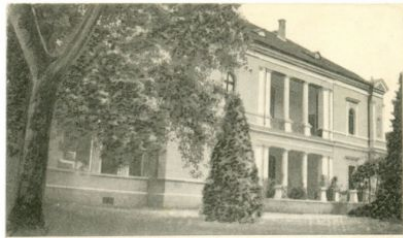
Bodola. Posta-Telegráf-Tábeszélő (főútszél-m.)
